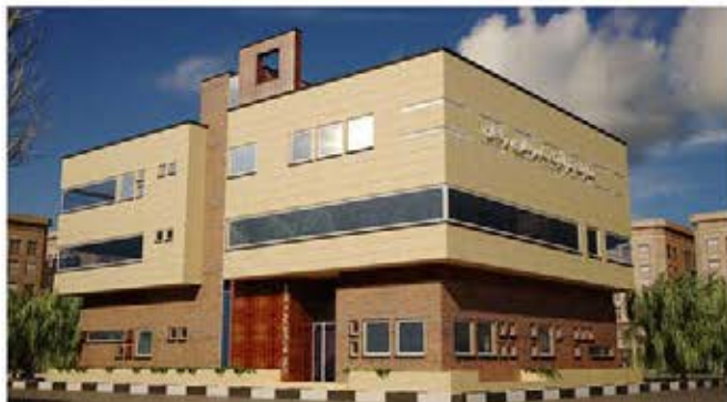
ساختمان معاونت ترافیک شهرداری زنجان
